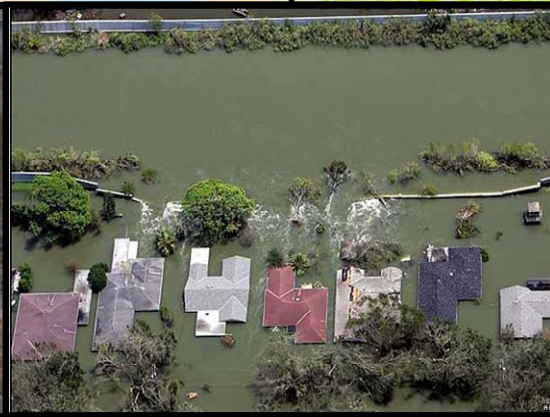
London Ave. Canal Breach
